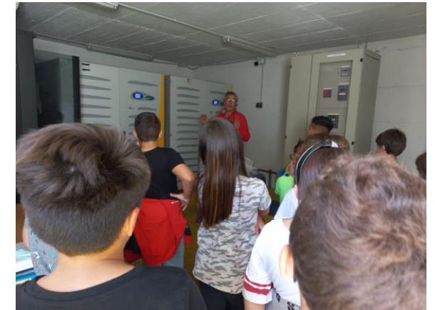
Centro di controllo del Parco fotovoltaico
